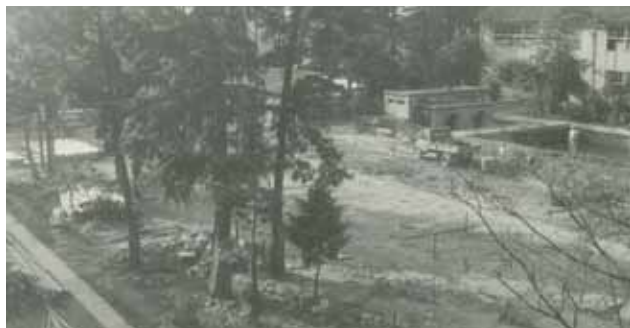
鉄筋校舎への改築/ 昭和37年(1962年)12月頃 解体時、1-2号館中庭樹木が大切に残された様子が分かる。
